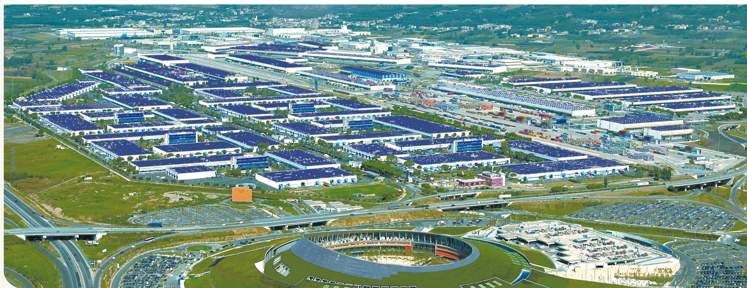
Fig.1 Centro Logistico, Nola Superficie: 590.000 m 2 - Potenza: 20,252 MWp
